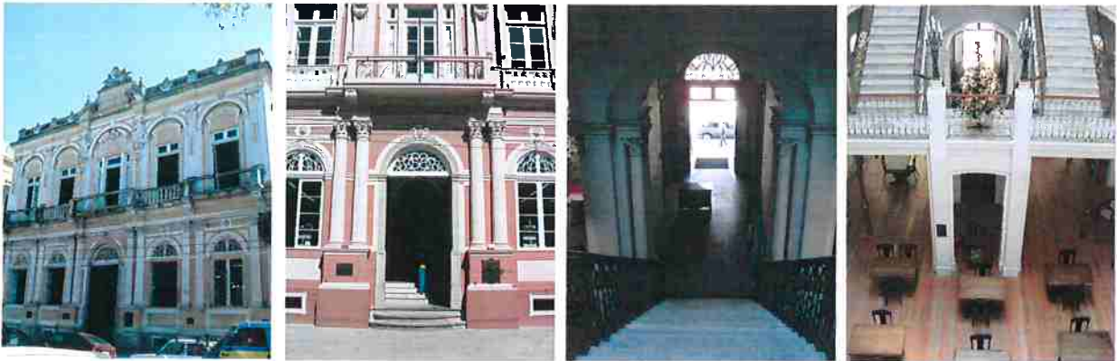
Ilustração 17. Biblioteca Pública Pelotense: fachada principal, hall e escadaria. Fonte: ARS.
